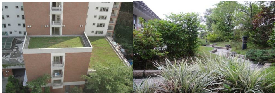
屋頂隔熱系統(左：宿舍大樓、右：設計大樓)
